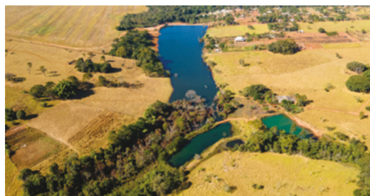
Aporte será de R$ 17 milhões para construir mais dois reservatórios metálicos; assim, capacidade passa de 10 milhões para 20 milhões de litros
